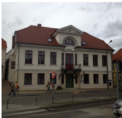
Alexandrinenplatz 5 (Denkmal – voll saniert)
