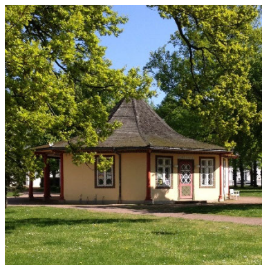
Kamp – Roter Pavillon (Denkmal – teilsaniert)
